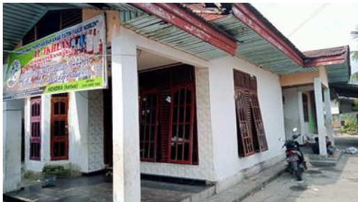
Gambar 1. Bangunan Panti Tampak Depan
