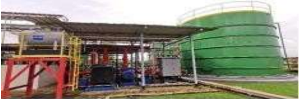
Gambar 4. Pompa Pemadam Kebakaran PLTGU PT. Krakatau Chandra Energi
