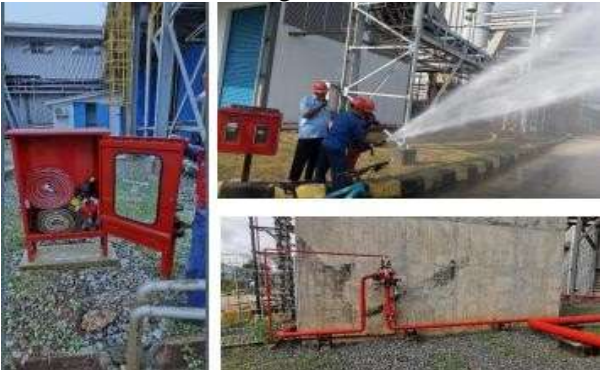
Gambar 1. Sistem Pipa Tegak dan Hidran PT. Krakatau Chandra Energi
