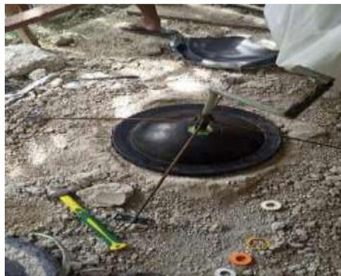
**Gambar 14 Pemansangan pengaduk manual ke digester manual**
