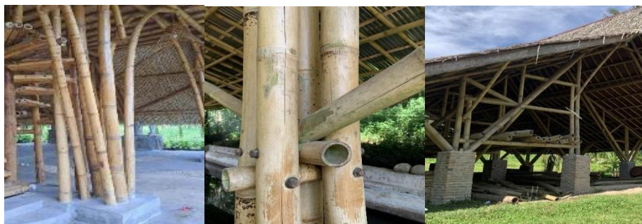
Gambar 5. Detail konstruksi kolom bambu petung (Ø250mm) dengan sistem sambungan hibrida
