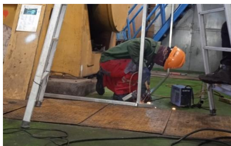
Gambar 1. Proses Pemasangan Partisi Mesin Deutz
