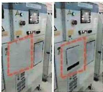
Gambar 5 Nampak Controller Conveyor Sebelum dan Sesudah Dilakukan Pemasangan Fan
