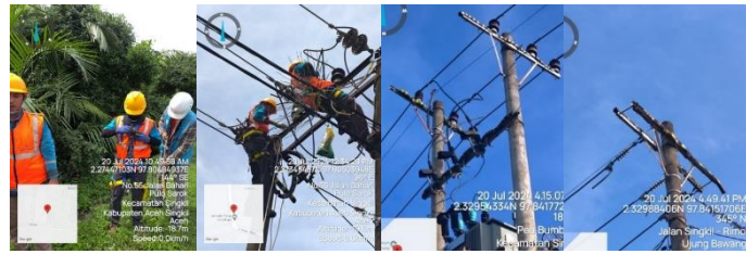
Gambar 3. Eviden Pengawasan Pemasangan dan Hasil Pemasangan Ban Bekas pada Bracket
