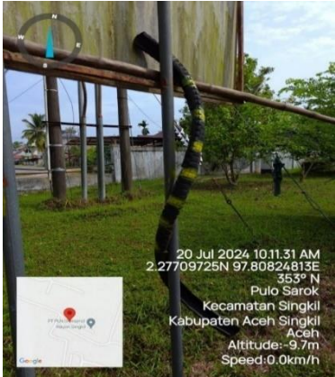
Gambar 2. Eviden Pengecatan Ban Bekas untuk Menakuti Hewan di Bracket
