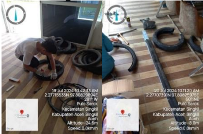
Gambar 1. Proses Pemotongan Ban Bekas untuk Penghalau Hewan di Bracket
