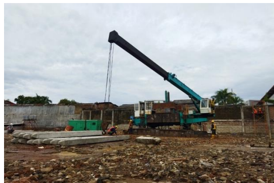
Gambar 3. Pengikatan Tiang Pancang
