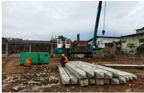
Gambar 2. Mobilisasi alat ke titik pemancangan
