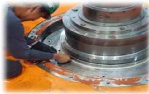
Gambar 4: Pengambilan Data Clearance Unit 2 PLTA Maninjau
