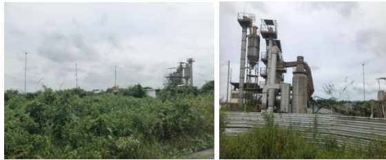
Gambar IV. 1 Antena NDB dan Cerobong AMP DAN Struktur bangunan AMP Sumber: 2024, Dokumentasi Peneliti
