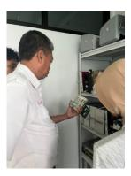
2. Kemudian peralatan Glide Path dimatikan dan modul TCA (Transmitter Control Assembly) dilepas dari rak kabinet
