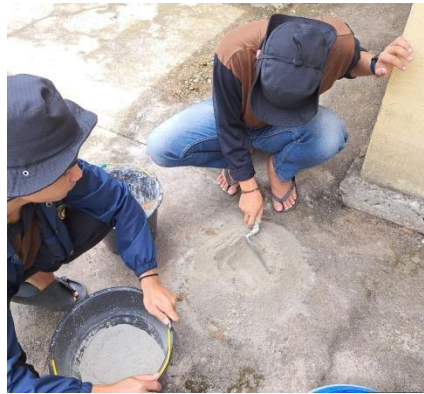
Gambar 6. Proses Pemasangan TOGA
