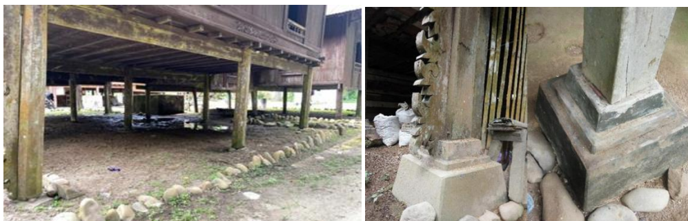
Gambar 2 dan 3. Rumah Lontiok dan Tiang Rumah Lontiok Desa Pulau Belimbing
