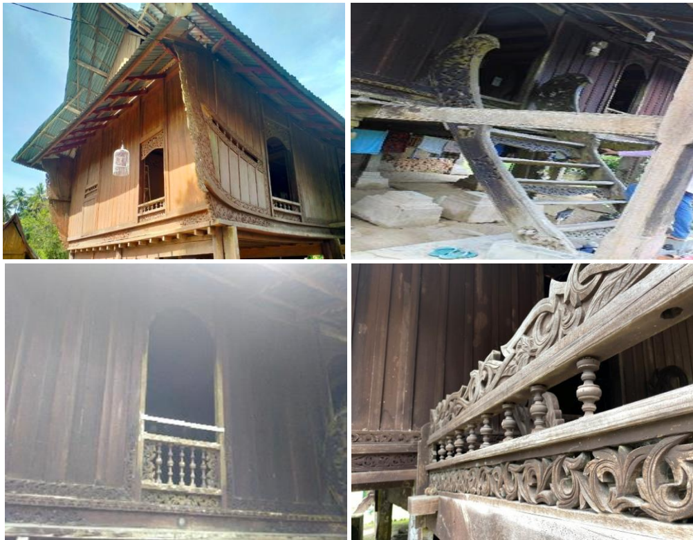
Gambar 13,14,15,16. Ragam Hias Ukiran Pada Rumah Lontiook Desa Pulau Belimbing
