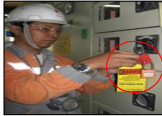
Gambar 3. Autoritas Elektrik Melakukan Lock Out Tag Out di MCC
