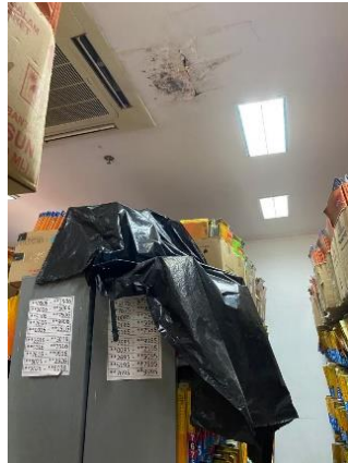
Gambar 2. AC yang Mengalami Kebocoran
