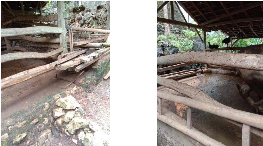
Gambar 2. Kandang ternak dengan lantai semen dan terdapat jalur urine untuk mengalirkan ke bak penampungan
