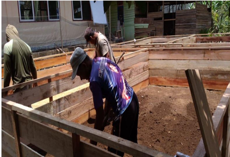
Gambar 2. Pekerja pepadatan lantai dasar kolam dengan pasir urug
