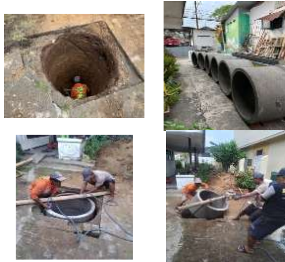
Gambar 5. Proses Pembuatan Sumur Resapan
