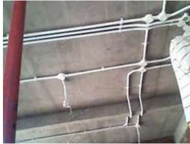
Gambar 8 .Instalasi listrik yang rapi dan aman
