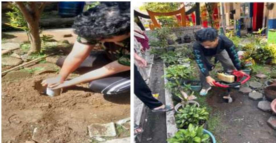
Gambar 5 : Pemasangan Lubang Resapan Biopori
