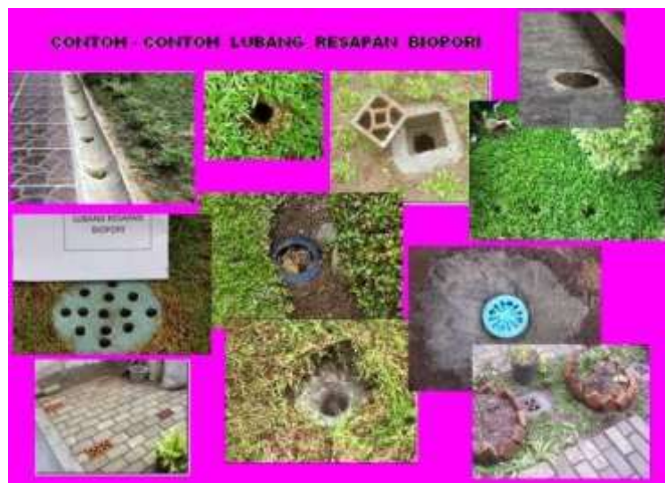
Gambar 2 : Contoh Pipa Lubang Resapan Biopori di Perumahan Warga (Sumber: agamkab.go.id)
