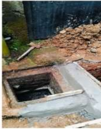
Gambar 3. Pembuatan bak kontrol
