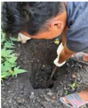
Gambar 3. Pembuatan lubang LRB
