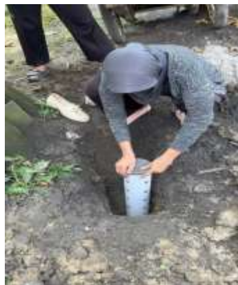
Gambar 4. peletakan paralon PVC
