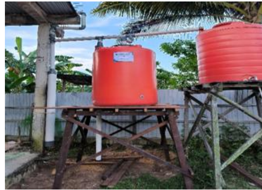
Gambar 8. Sistem PAH siap digunakan
