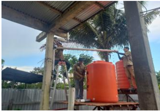
Gambar 7. Proses instalasi PAH
