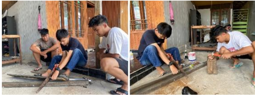
Gambar 3. Pembuatan Bekisting dari kayu bekas.
