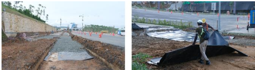
Gambar. 2 Tahapan Penghamparan Geomembran HDPE dan Lapis Drainase
