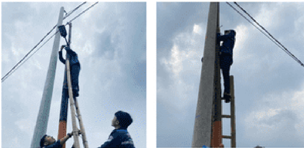
Gambar 4. Kegiatan Proses Pemasangan Lampu
