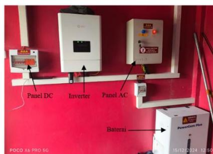
Gambar 4. Hasil pemasangan inverter dan baterai
