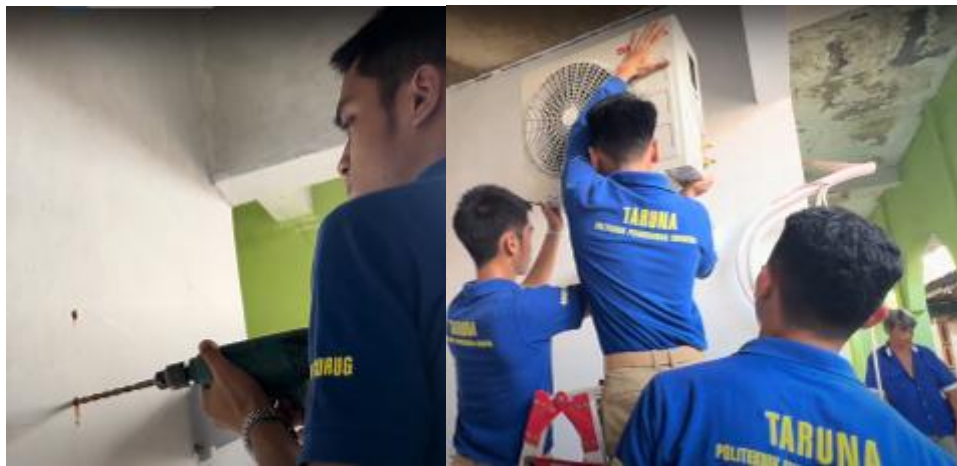
Gambar 9. Pemasangan Unit Outdoor
