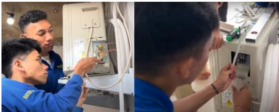
Gambar 10. Penyambungan kabel kelistrikan dan pipa refrigerant
