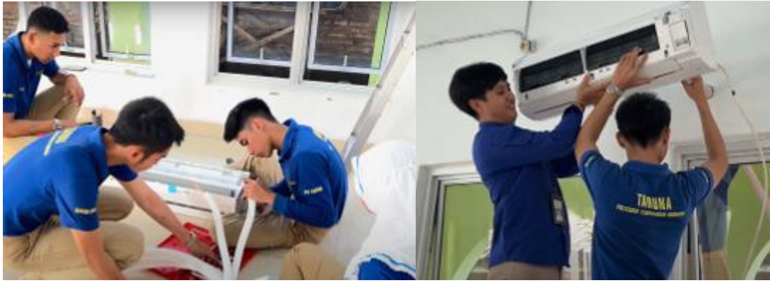
Gambar 8. Pemasangan Unit Indoor
