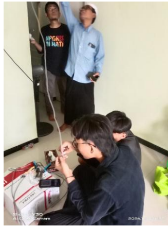
Gambar 3. Kegiatan pembenahan instalasi jaringan internet
