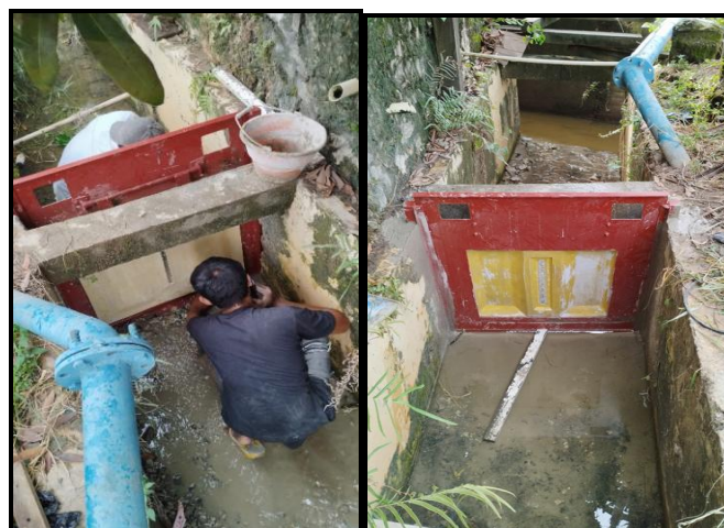
Gambar 7. Pemasangan Pintu Air
