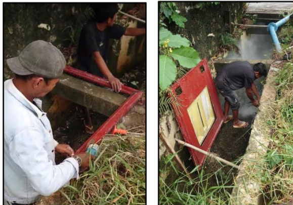
Gambar 6. Pemotongan Frame dan Pembobokan Dinding Saluran
