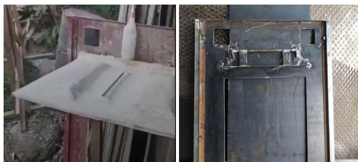
Gambar 5 Pabrikasi Pintu Air
