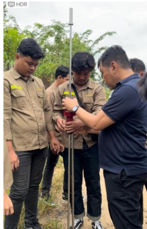
Gambar 5. Pelaksanaan Uji DCP titik 2 di lokasi Jalan Usaha Tani, Desa Manunggal Jaya, Kab. Kutai Kertanegara, Kalimantan Timur
