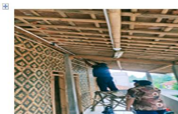
Gambar 5. Pemasangan instalasi listrik pemondokan santri lantai atas
