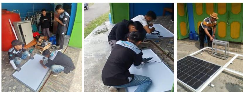
Gambar 3. Proses pemasangan dan instalasi PLTS
