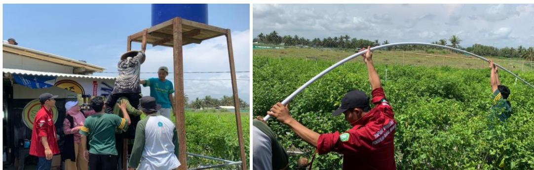
Gambar 3. Proses memasang alat pendukung sprinkle berupa tandon air dan pipa sprinkle.
