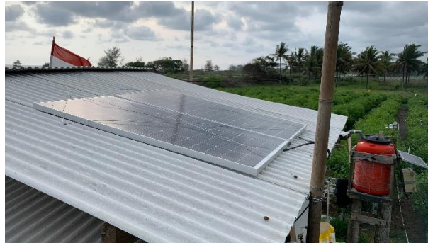
Gambar 4. Pemasangan Solar Cell
