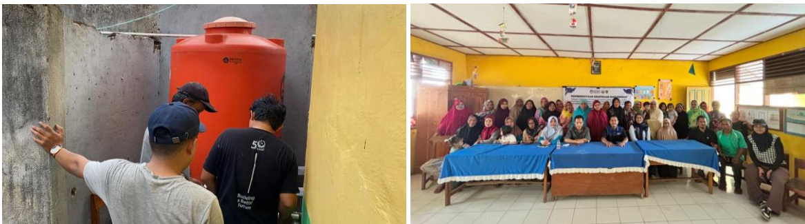
Gambar 4. Pemasangan bak air baku dan pelatihan sistem PLTS
