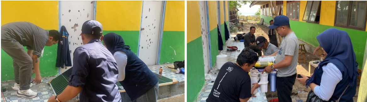
Gambar 3. Pemasangan Panel Surya oleh Kepala Sekolah dan Pendampingan Pemasangan Mesin Reverse Osmosis
