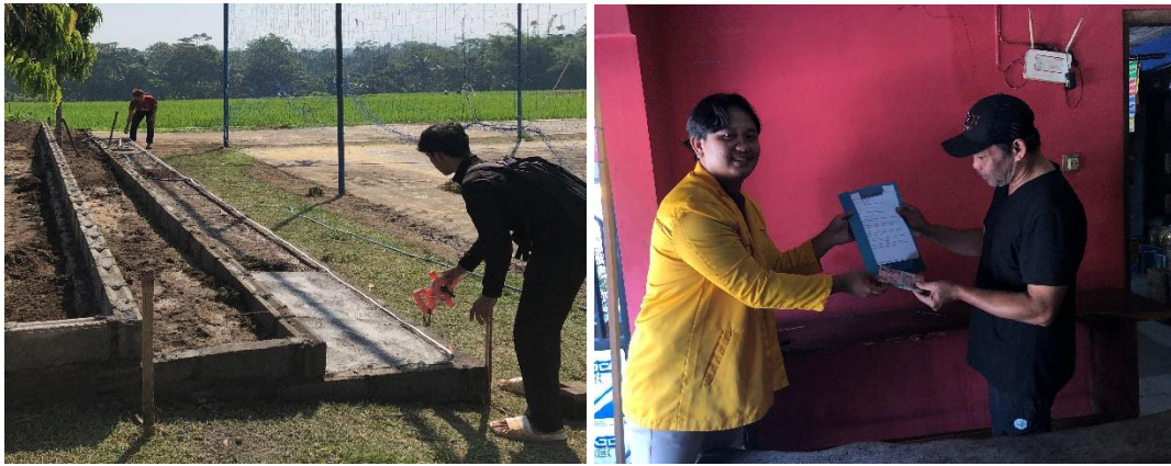
Gambar 5. Pembangunan fasilitas dam Penyerahan dana pembangunan kepada perwakilan masyarakat
