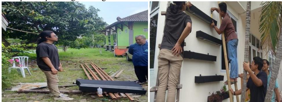
Gambar 5 Proses Pengeringan Cat dan Proses Pemasangan Talang PVC pada Dinding
