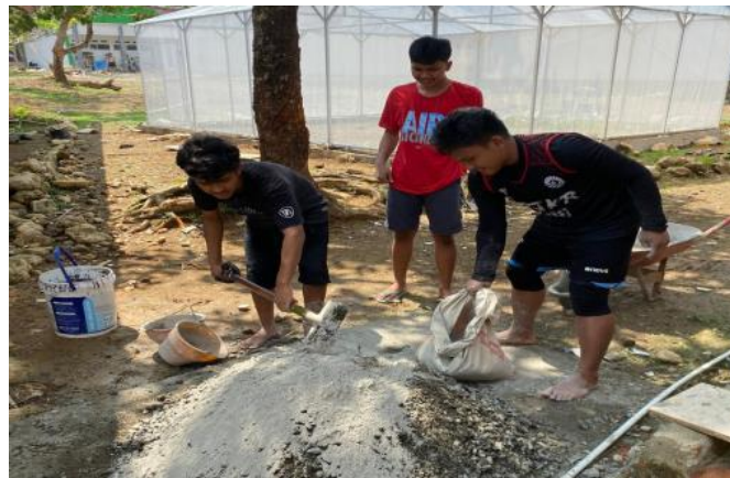
Gambar 2. Pengecoran Pondasi Greenhouse
