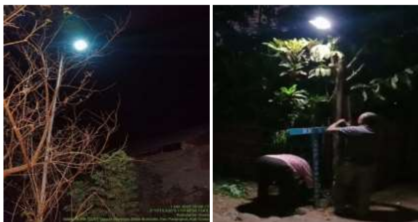
Gambar 5. Proses pemasangan panel surya untuk penerangan jalan desa yang dilakukan secara gotorng royong oleh warga Desa Borisallo didampingi Tim PKM
