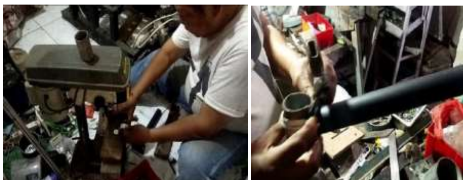
Gambar 3. Proses penyiapan dan pembuatan rangka untuk tiang panel surya
