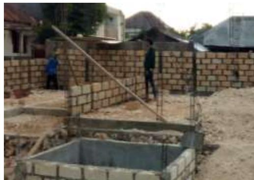
Gambar 10. Pekerjaan Pemasangan Dinding
