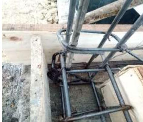
Gambar 11. Detail Penulangan Pertemuan Balok Sloof dengan Kolom dengan Tulangan Memanjang  $\phi 12$  mm, Sengkang  $\phi 8$  mm dan Jarak antara Sengkang 15 cm
