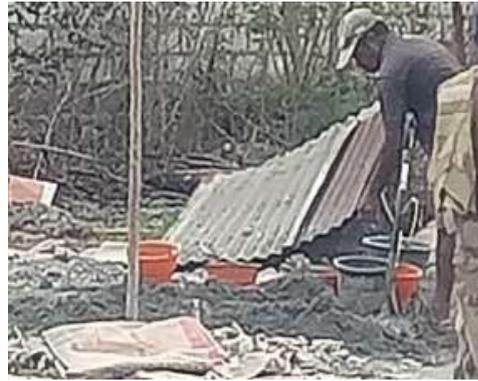
Gambar 13. Pekerjaan Pencampuran Material Sebelum Pengecoran
