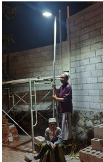
Gambar3. Pendampingan Pemasangan PLTS oleh Mitra
