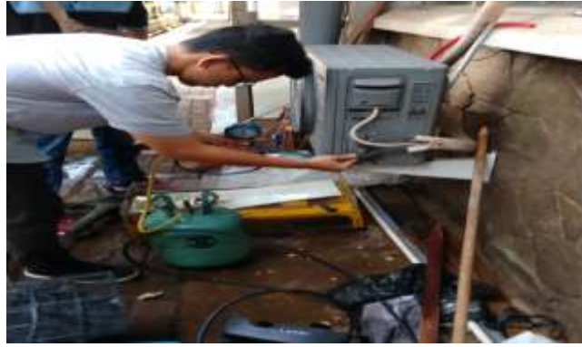
Gambar 2. Pendampingan Perawatan AC Spilt kepada Mitra
