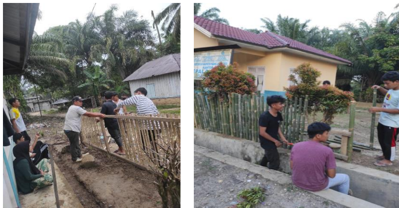
Gambar 3. Pemasangan pagar Kantor PKK dan Kantor kepala Desa Ulak Tano
