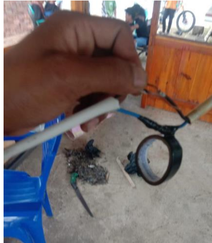
Gambar10: Instalasi listrik yang telah diperbaiki
