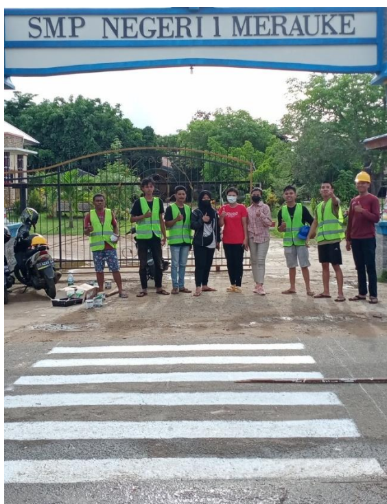
Gambar 9 Finalisasi pengecatan Zebracross
