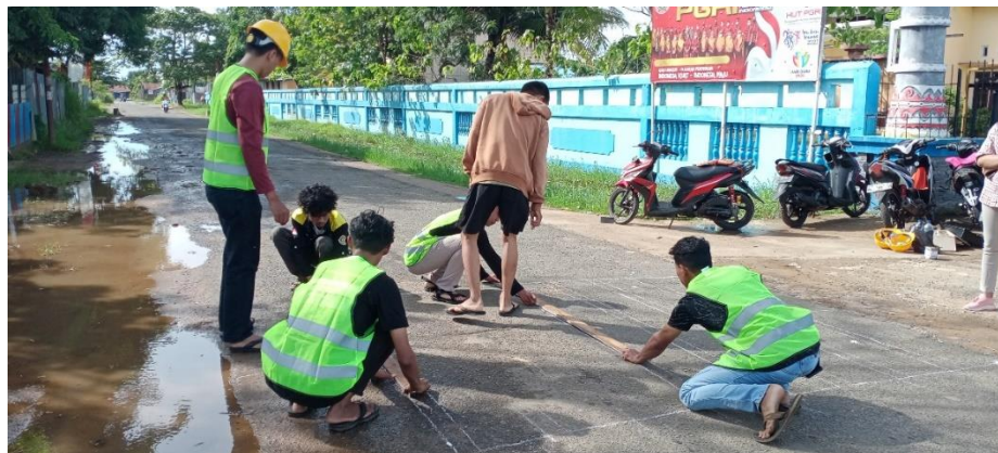
Gambar 7 pembuatan mall pada jalan Pendidikan untuk pembuatan zebra cross
