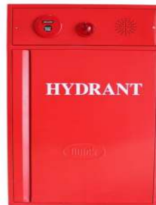
Gambar 10 Hidran gedung
