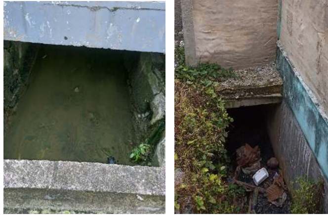
Gambar 7. Saluran Tertutup Bangunan
