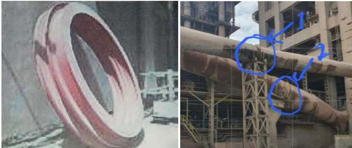
Gambar 5. Exspantion Joint sebelum terpasang dan sesudah terpasang
