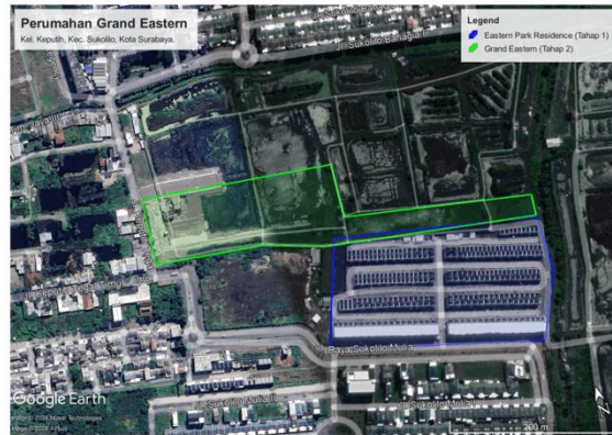
Gambar. 2. Peta Lokasi Proyek Pembangunan Perumahan Grand Eastern Suarabaya.
